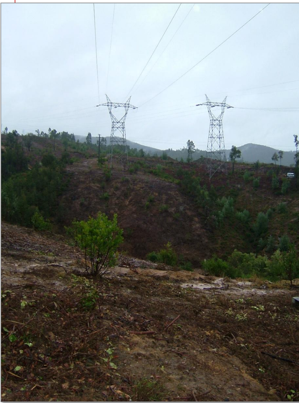
Fig. 8 – Linhas de alta tensão ocupadas por medronheiros
